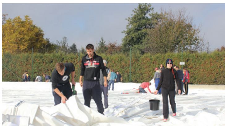
Razgrnitev in šivanje membrane
