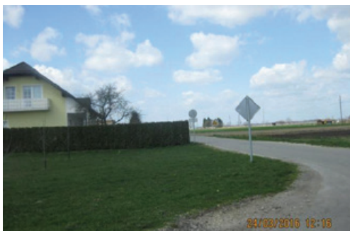
Nepreglednost cestnega priključka
